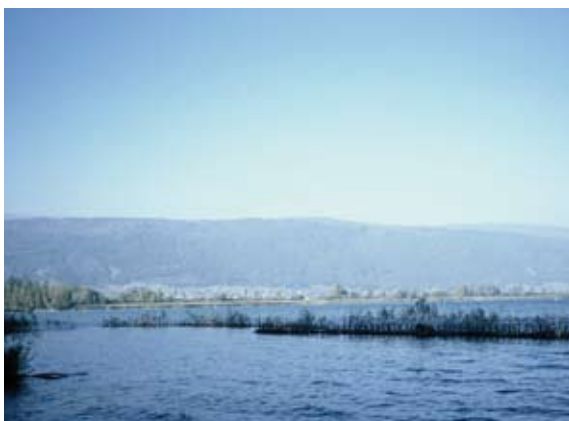
Abb. 4.42: Uferschutzmaßnahmen mittels Lahnungen (Bieler See)
