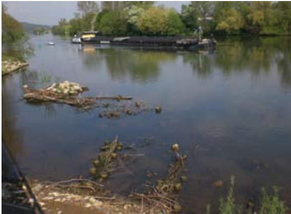
Abb. 2.28: Strukturfaschinen und Steininseln (Körschmündung bei Deizisau)
