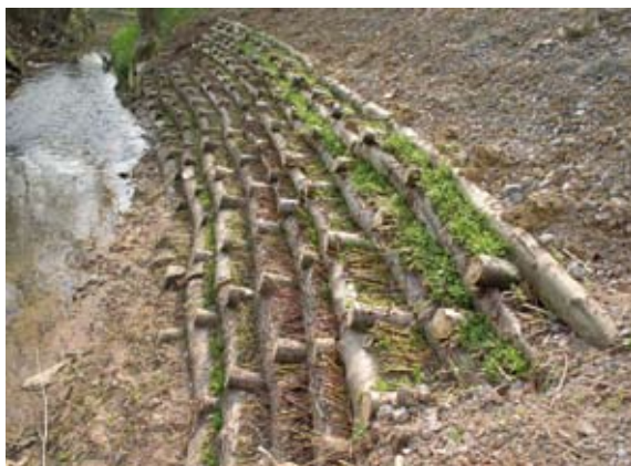
Abb. 4.32: Krainerwand (Bottwar bei Oberstenfeld)
