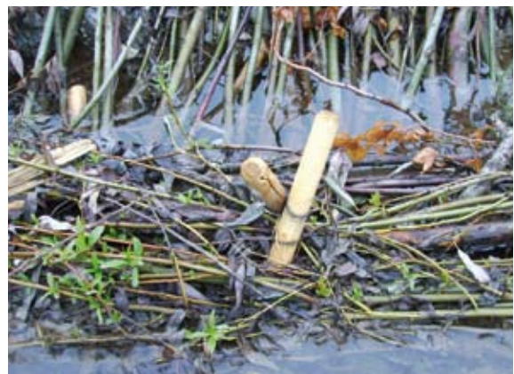
Abb. 4.4: Sicherung mit Pflocken (Gießnaubach in Nabern/Teck)
