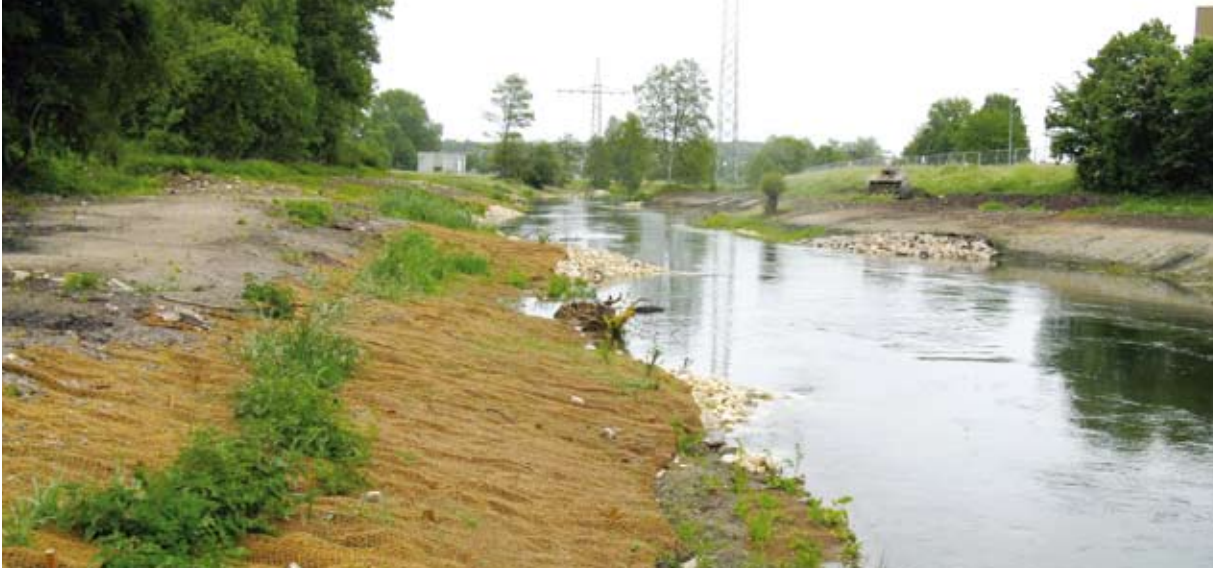
Abb. 4.39: Böschungsschuttmatten zur Sicherung von Pflanzung und Ansaaten (Brenz in Giengen)
