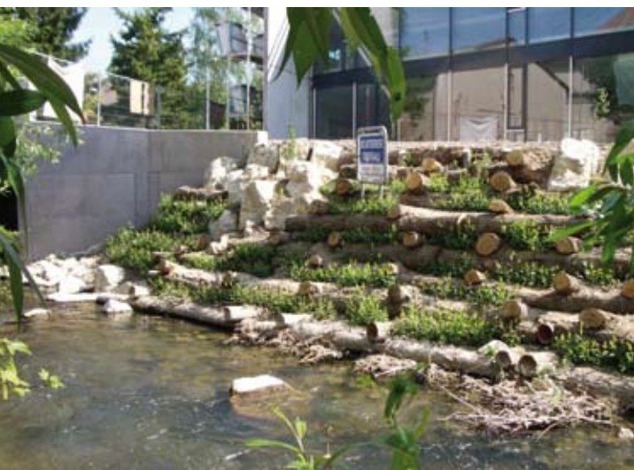
Abb. 2.14: Krainerwand und Steinsatz (Lauter in Kirchheim)
