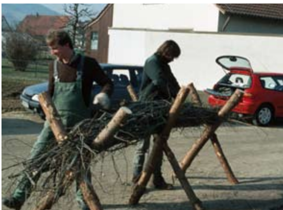
Abb. 4.3: Einfacher Faschinenbock (Gießnaubach in Nabern/Teck)
