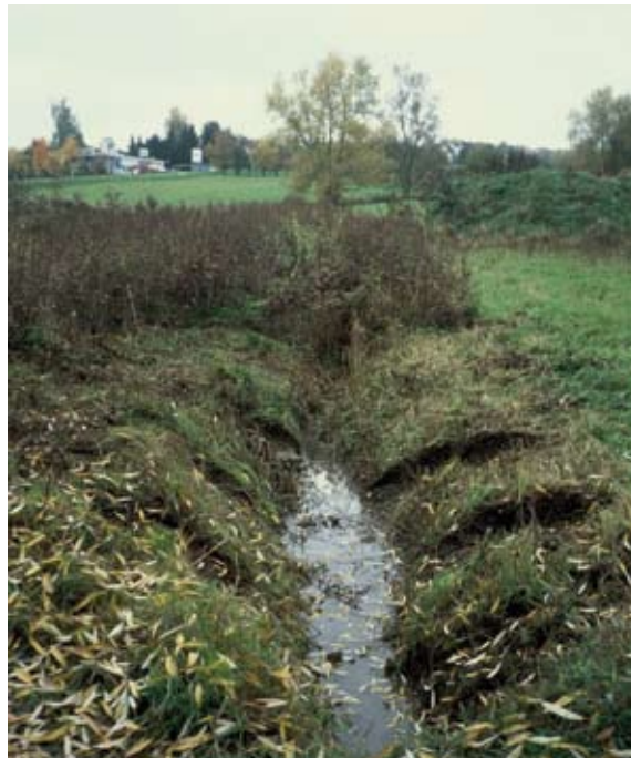
Abb. 3.8: Entnahme von Hochstaudensoden (Bonlandenbach in Reutlingen)
