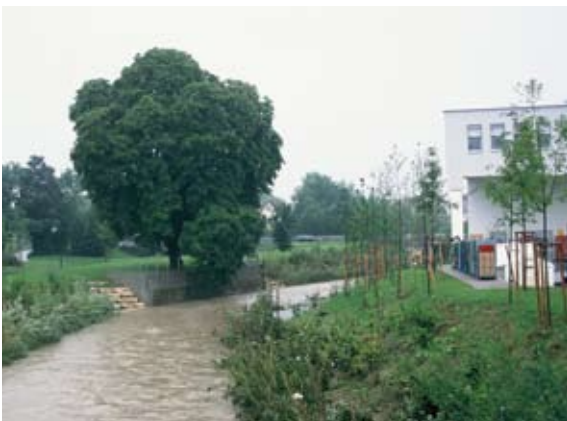
Abb. 3.21: Hochwasser drei Jahre nach Fertigstellung
