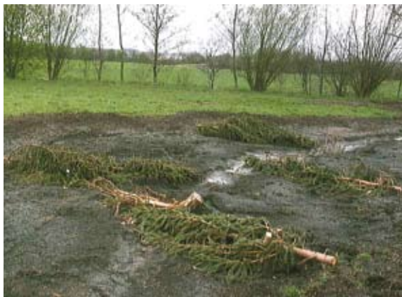
Abb. 2.18: Raubbäume zur Sohlenanhebung (Öfelesbach in Gärtringen)
