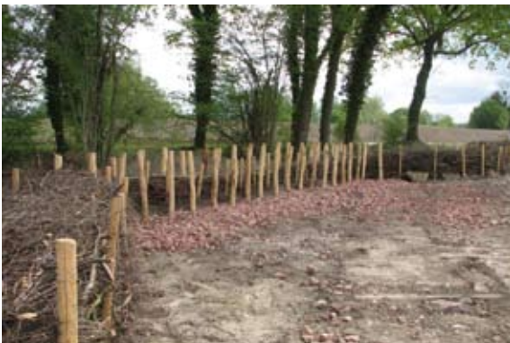
Abb. 2.40: Lahnung als Geschwemmselg bei Deichrückverlegung, im Bau (Leopoldskanal bei Rheinhausen)
