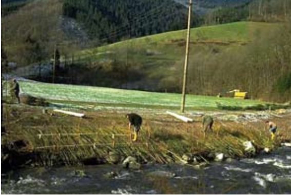
Abb. 2.38: Weidenspreitlage zur Kontrolle des Japanknöterichs im Bau (Wolf in Oberwolfach)
