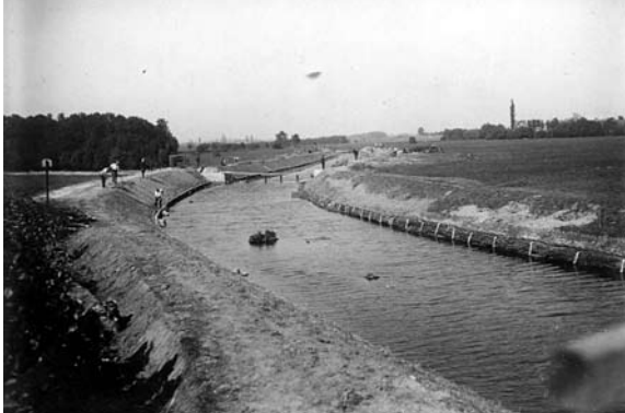
Abb. 2.4: Einbau von Faschinen an der Alten Rench, 1920
