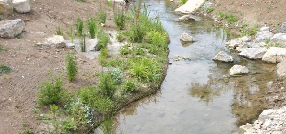
Abb. 4.36: Vegetationswalze (Rankbach bei Renningen)
