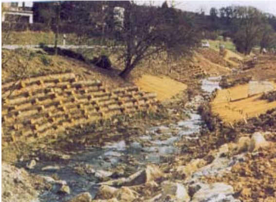
Abb. 3.15: Krainerwand nach Fertigstellung
